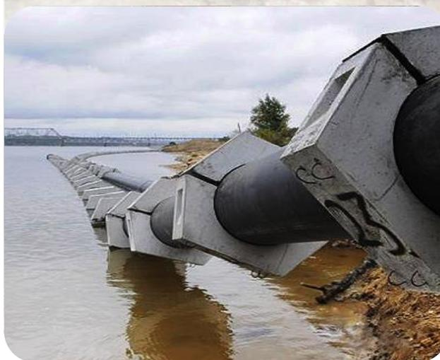
Уникальные характеристики спиральновитой трубы позволяют использовать ее в канализационных коллекторах на территориях с подвижными грунтами, для технологических водопроводов, колодцев и других гидротехнических сооружений, а также как емкости для воды, пищевых и химических продуктов. Спиральновитые трубы из полиэтилена являются актуальной альтернативой традиционным бетонным трубам.
